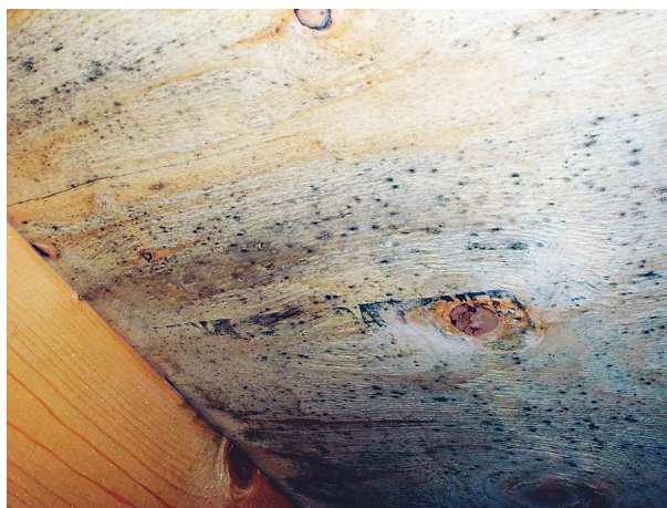
Figur 1: Exempel på olika fuktskador.
